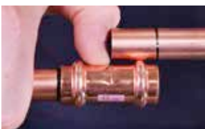
7b. Vérifiez la marque de profondeur
