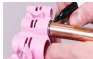
7a. Repérez la profondeur d'insertion sur le tube à l'aide d'une jauge de profondeur
