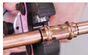
9. Positionnez les mâchoires directement sur le raccord
