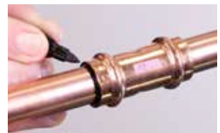
7b. Sinon, insérez le tube dans la butée du tube et marquez-le
