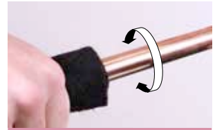
4. Nettoyez l'extrémité du tube
